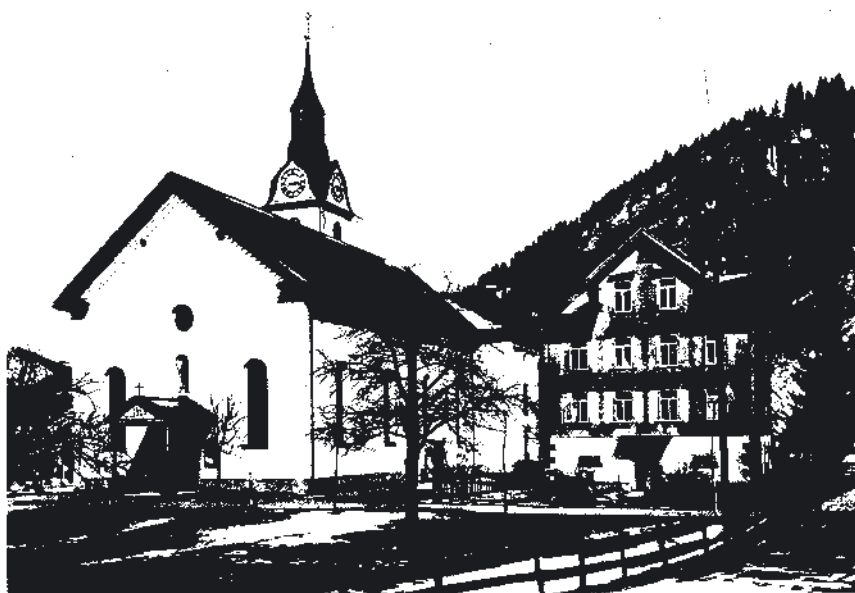
Kirche und Pfarrhaus vor der Renovation
