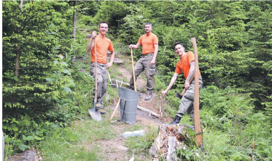
Die Arbeiten fanden in teils unwegsamem Gelände statt.
