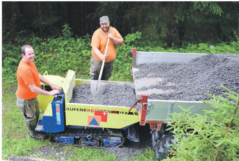
Den Kies transportierte der Zivilschutz mit einem Raupentransporter zu den Zwischenlagern.
