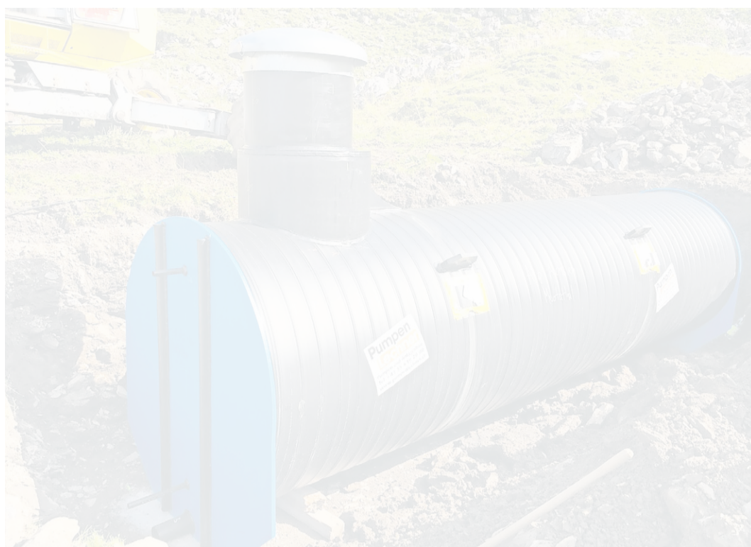
Das Wasser wird in solchen in den Boden verlegten Tanks gespeichert und sparsam abgegeben.
