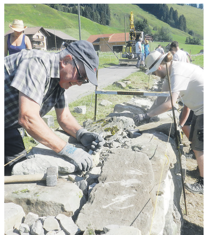
Zwischen den zwei Schalen werden Füllsteine eingebracht.
