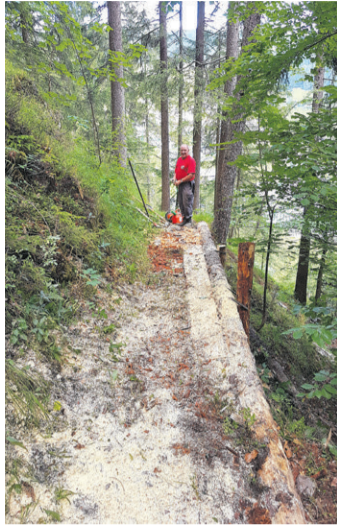
Walter Holdener bei der Erneuerung des Guggernweges, wo Wegteile abgerutscht sind. Foto: zvg
